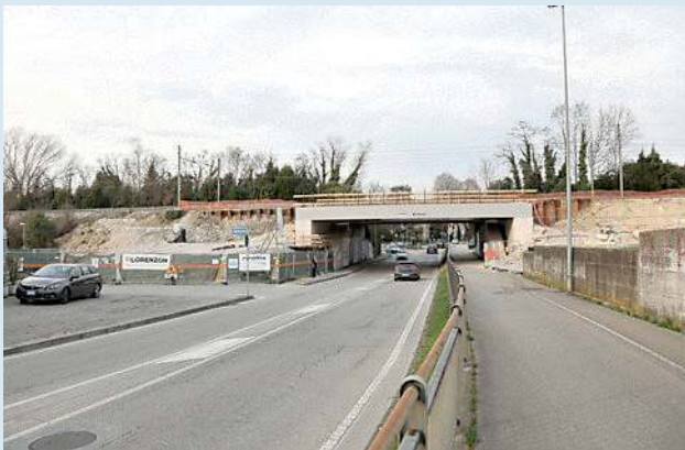
Il cantiere del raddoppio dell'asta di manovra FOTO AMBROSIO/PETRUSSI
